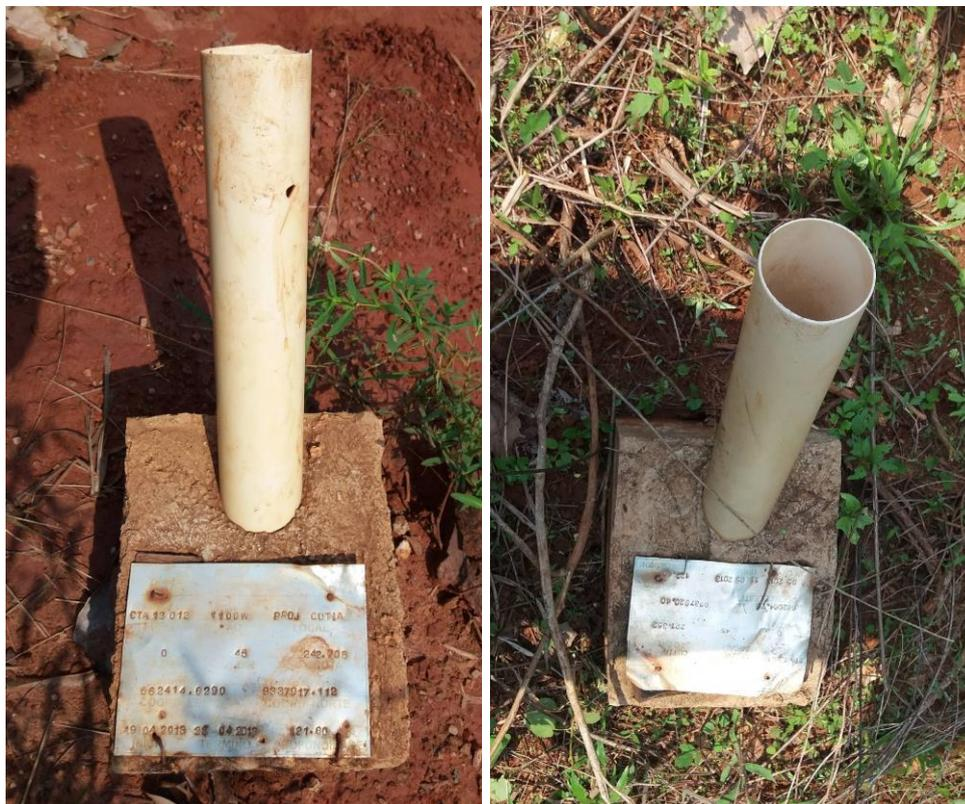
Figura 36. Marco de concreto implantado no local do furo com as informações descritivas.
